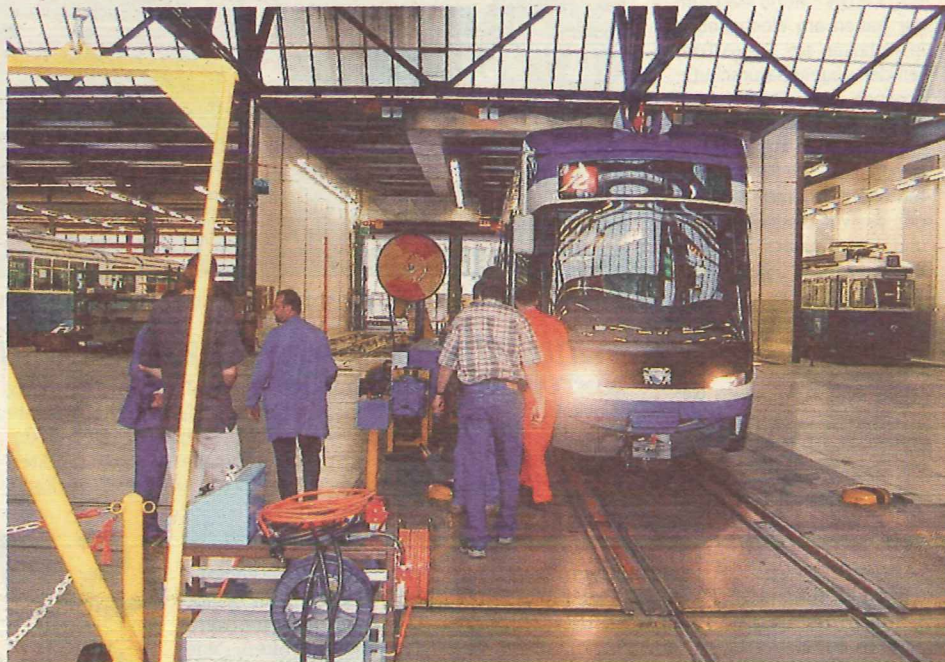
Die Arbeiten am Cobra-Tram sind nicht einfach: Allerneuste Tramtechnik kommt zum Zug.
